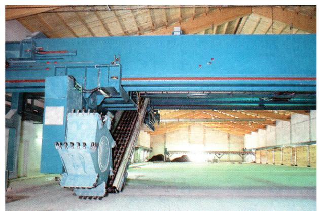
Die Mieten werden auf fünf Segmenten des Rottebodens errichtet. Jedes Segment ist mit eigenen Luftkanälen für die Belüftung der jeweiligen Mieten versehen. Dabei wird die Luft aus der Halle durch die Miete und durch die Belüftungsschlitze im Rotteboden und Luftkanäle gesaugt. Aus den Luftkanälen wird die Abluft zur Desodorierung über ein Biofilter in die Atmosphäre geblasen.
