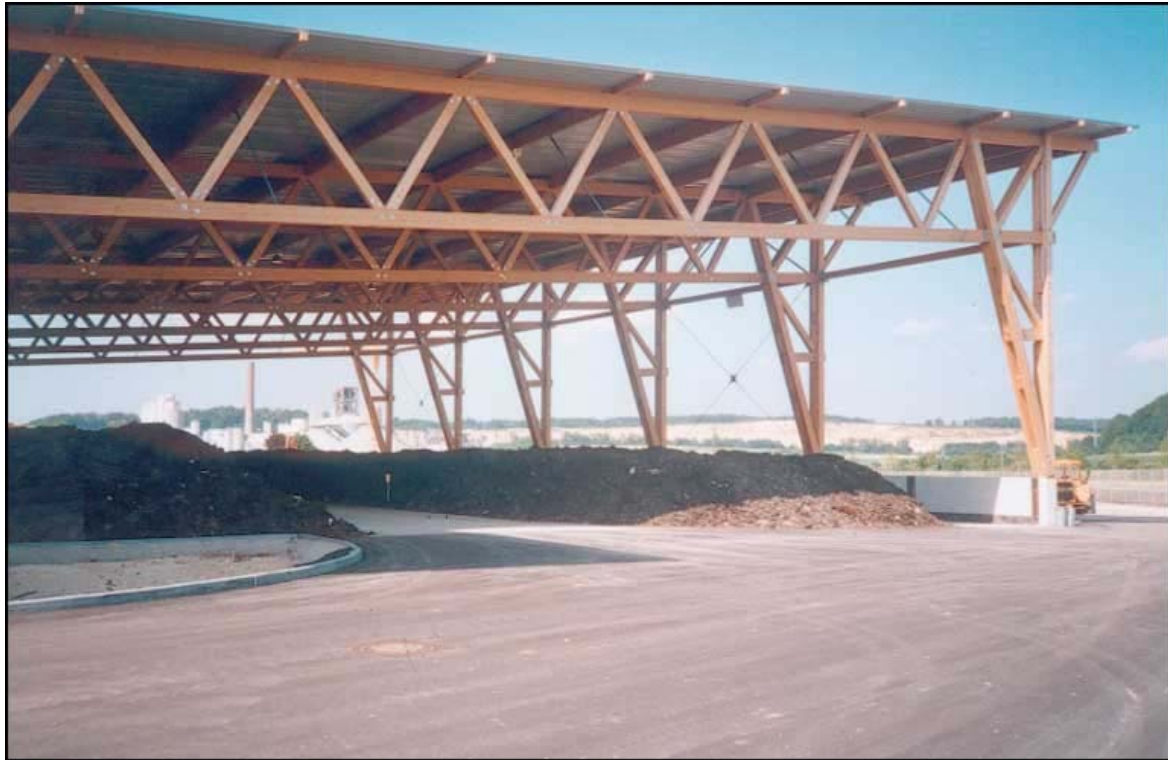
Fig. 5.29: Maturation Phase hall (Plant heidenheim, Photo: Ingenieurgesellschaft Abfall)
