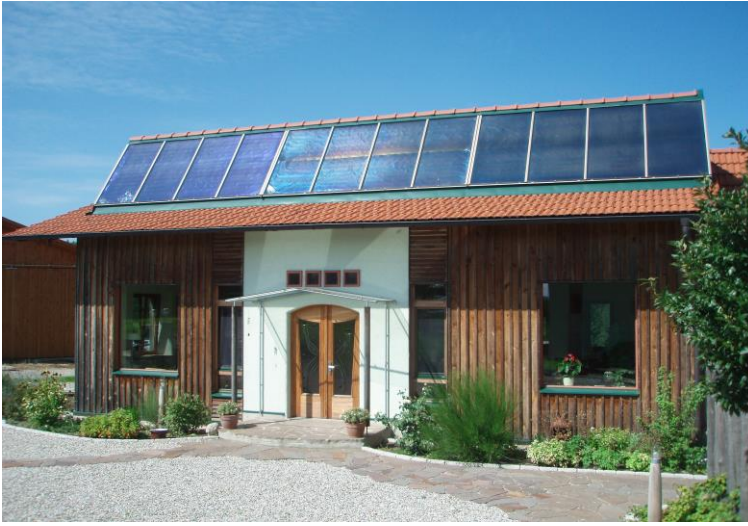
شكل (١٢-٥): مبنى من القش مع تزويدة بمجمع شمسي لتوليد الطاقة
