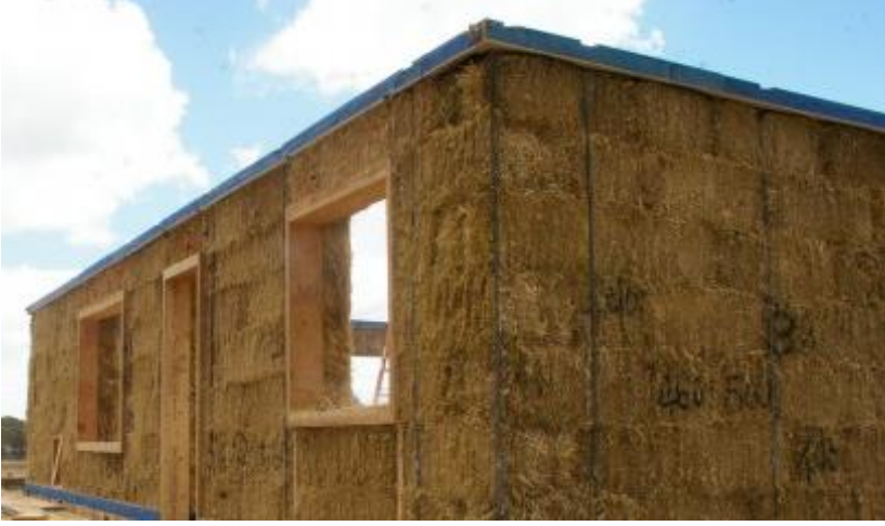
شكل (٥-٣): حائط بناء ببالات القش
